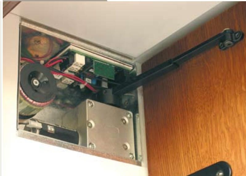
Oltre al motoriduttore Amer 24 Volt, una delle scatole ad incasso contiene la scheda elettronica ed il trasformatore che alimentano l'automazione
